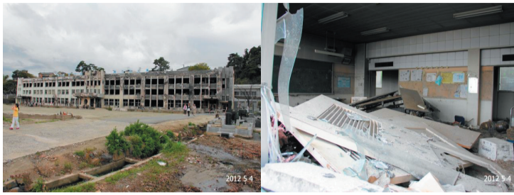
石巻市の門脇小学校。昨年の紅白で長渕剛が歌った場所。校舎の外は片付いていたが、教室の中はそのままの状態だった。全国から見に来ていた。
